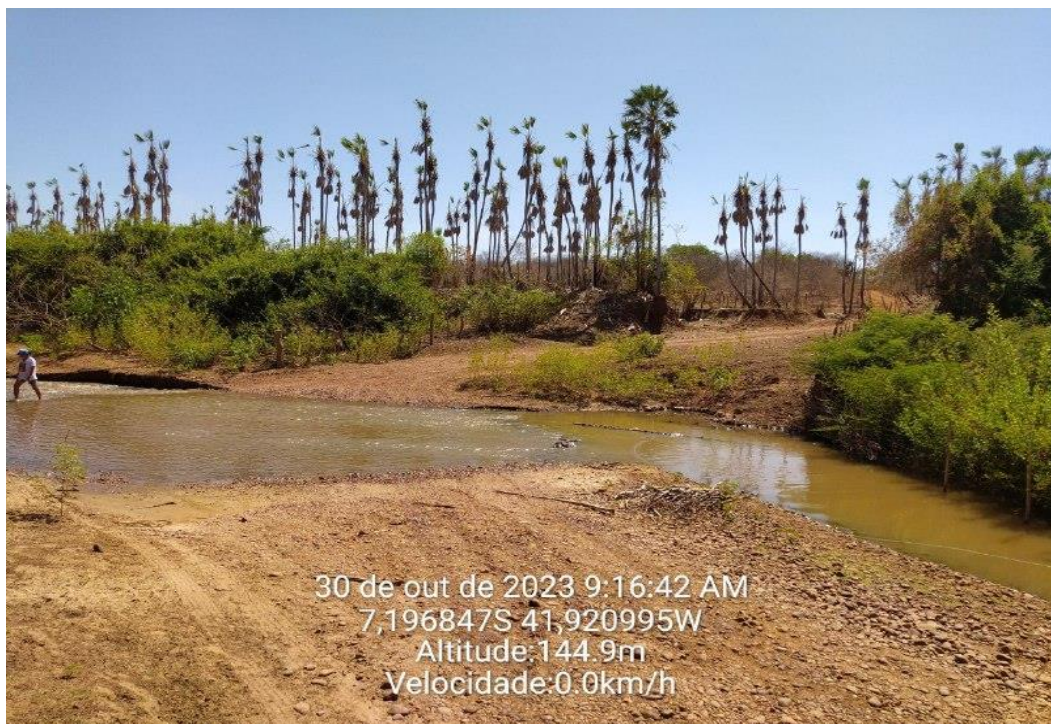
FOTO 10 - PASSAGEM MOLHADA 02 - TRECHO 01
