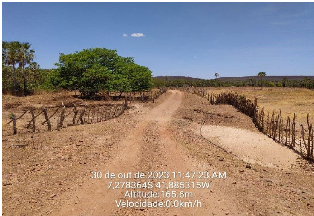
FOTO 10 - PASSAGEM MOLHADA 06 - TRECHO 04
