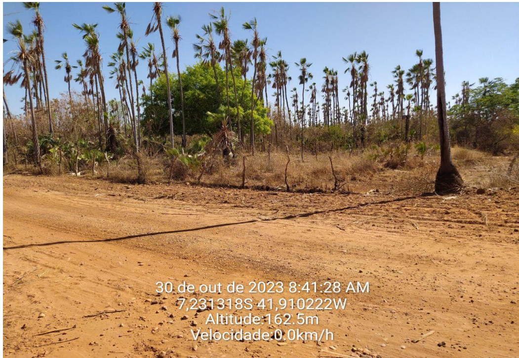
FOTO 09 - PASSAGEM MOLHADA 01 - TRECHO 01
