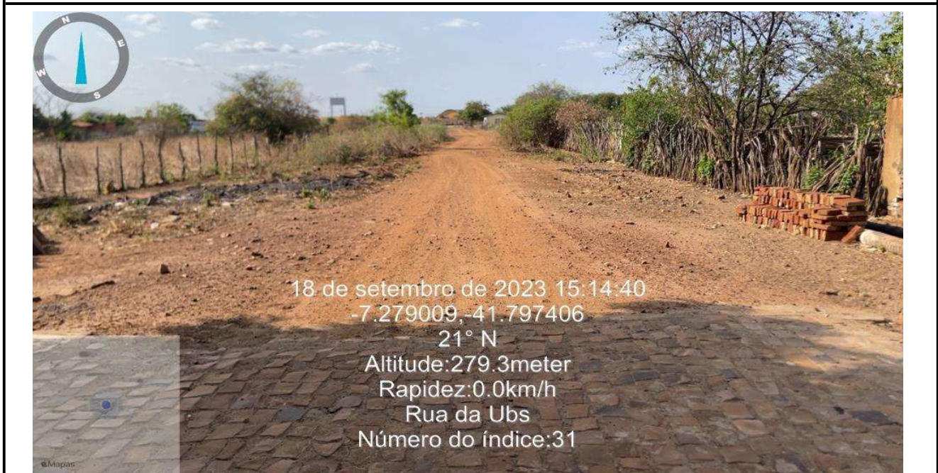
Foto Nº 02 - RUA DA UBS
